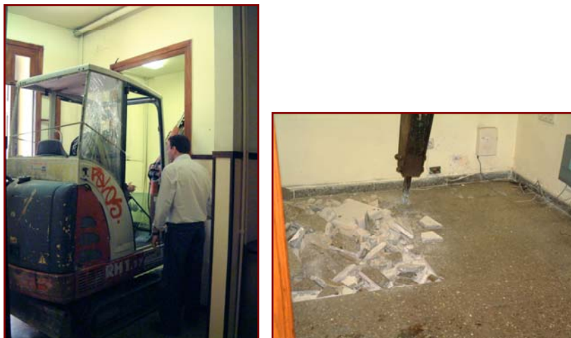
Situació de la màquina retroexcavadora durant els treballs realitzats a la Cala 1.
